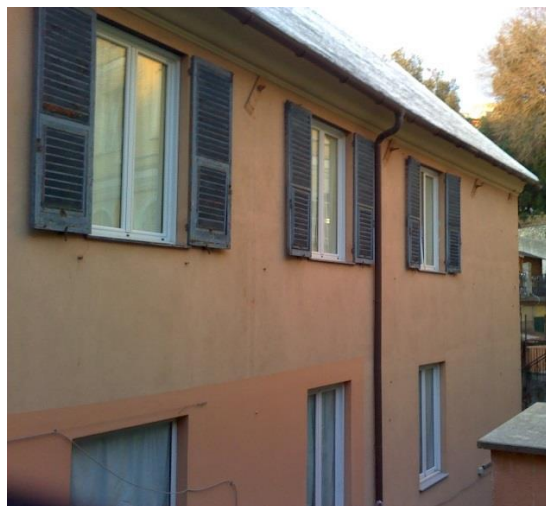
Figura 0.1 - Vista della facciata esposta a Est
