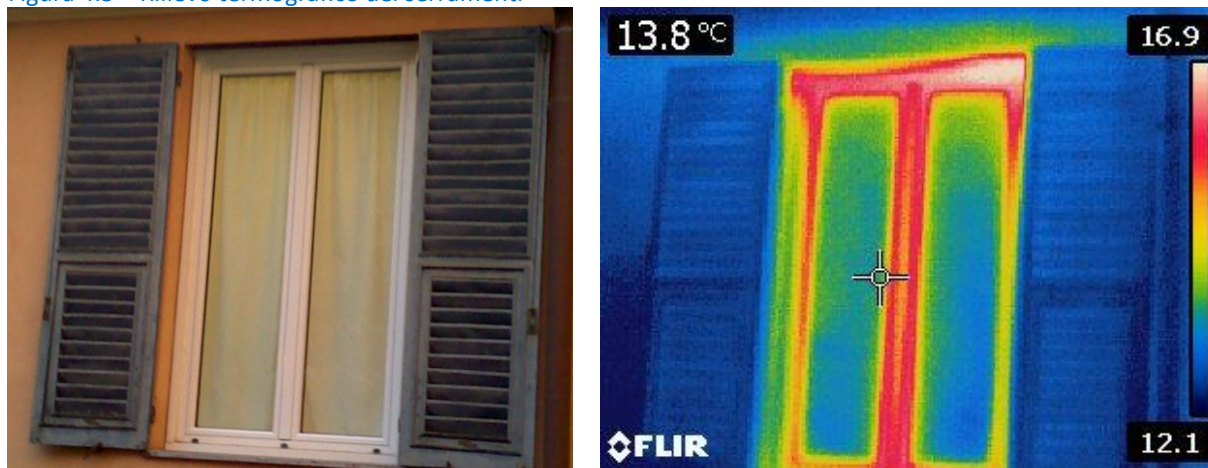
Figura 4.5 – Rilievo termografico dei serramenti
